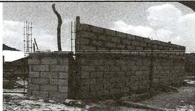
Foto 1: Fundicion de columnas
