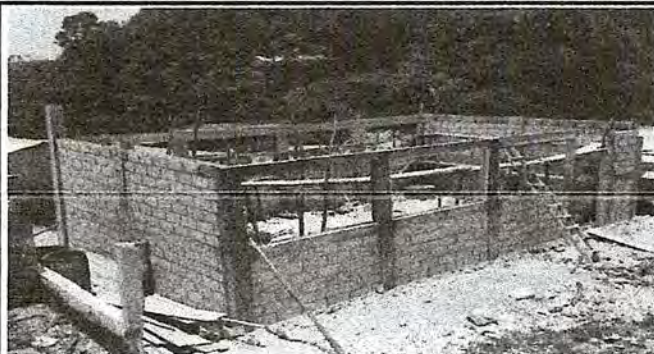
Foto 3: Desarmar tablas de las columnas
