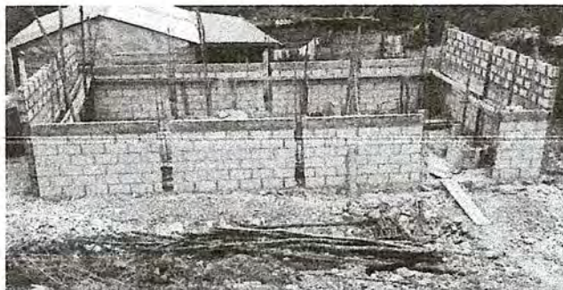
Foto 2: Fundicion de Soleras
