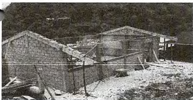
Foto 5: Colocando Corronacion de la escuela
